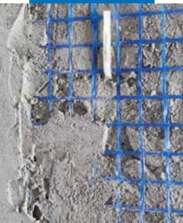
Applicazione del secondo strato di Planitop SR
