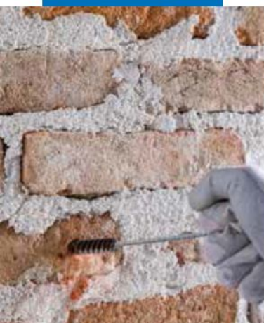
Asportazione delle polveri dai fori
