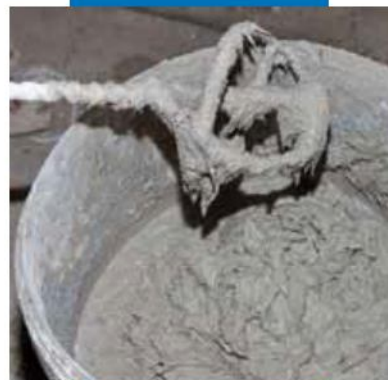
Miscelazione conclusa di Planitop HDM Restauro
