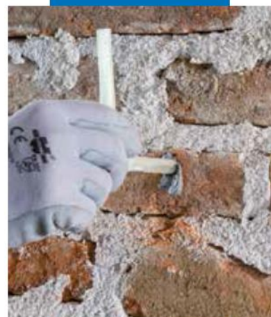
Posa di Mapenet EM Connector
