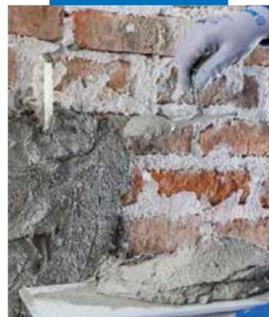
Applicazione del primo strato di Planitop SR
