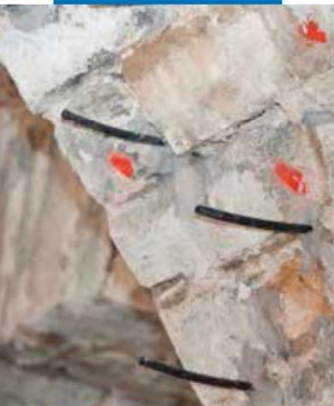
Particolare del fissaggio dei tubicini di iniezione
